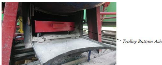
Gambar 3. 8 Kontruksi Bottom Ash Setelah Modifikasi
